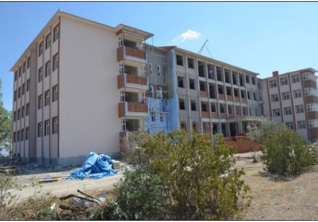
Yerleşkede inşa edilen yeni yapılar, 2014.
